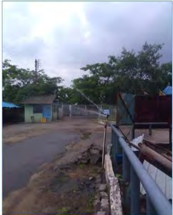
Fixed type of water sprinklers (Kondkel)
