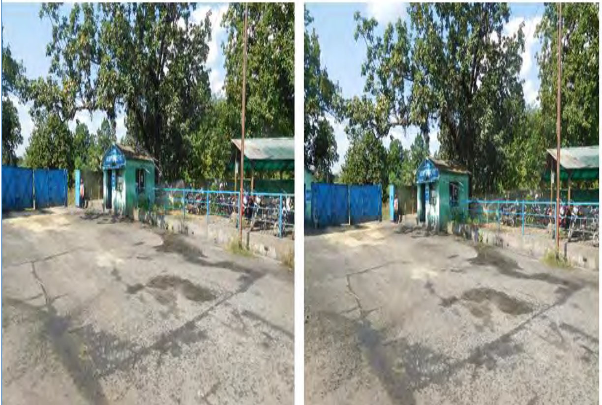
Fixed type of water sprinklers (Kondkel)
